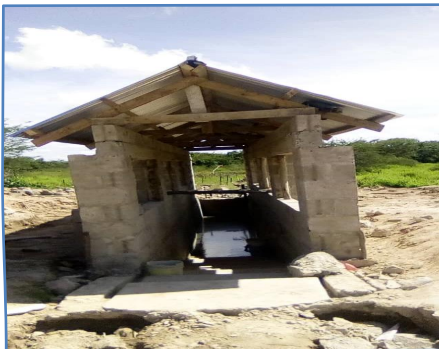
Ujenzi wa josho ukiendelea Kata ya Kakola
